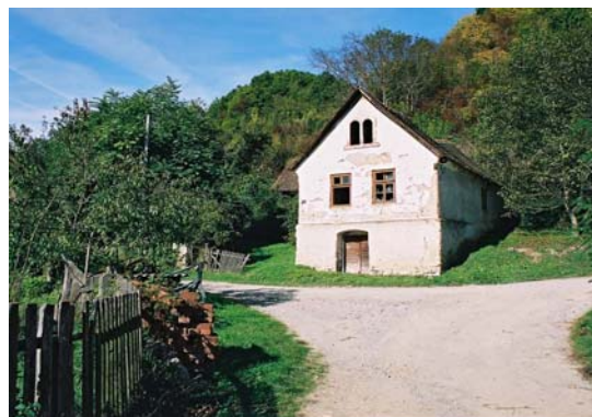
Sl. 22. Orljivac. Brdska visokoprizemnica
