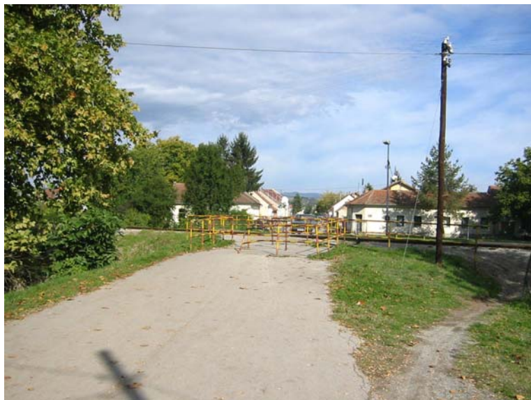
PRUŽNI PRIJELAZ PRIMORSKA ULICA
