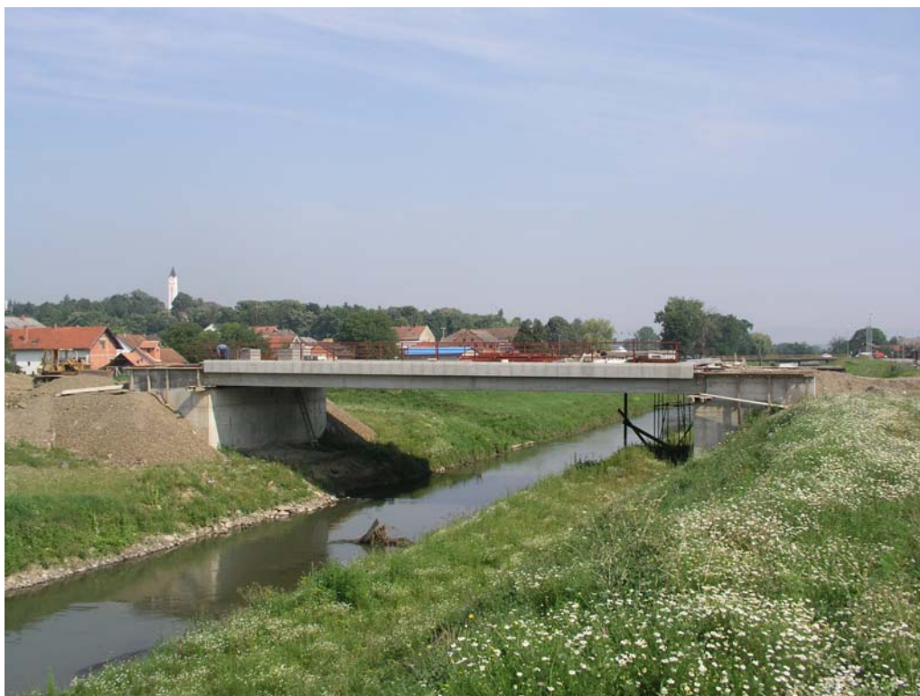
Novi most preko rijeke Orljave (u tijeku gradnje)
