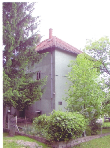
Sl. 5. Gradište – Zgrada škole
