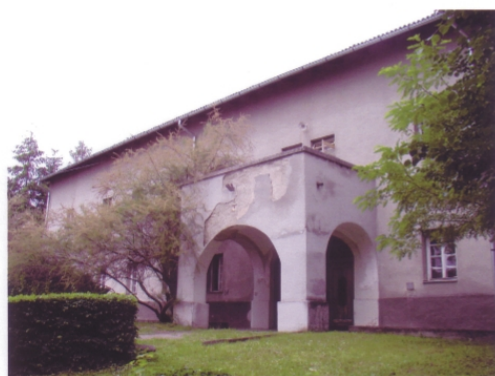
Sl. 21. Kutjevo – Stari dio upravne zgrade
